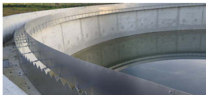
Bassin d'aération et clarificateur (les boues récupérées seront déshydratées et envoyées vers une usine de compostage)
