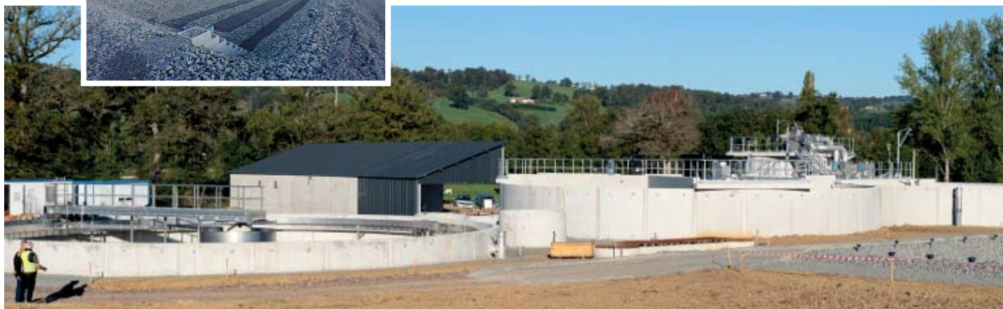
Bassin d'aération et clarificateur (les boues récupérées seront déshydratées et envoyées vers une usine de compostage)
