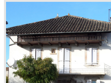
Placadou : petit plancher intégré à la charpente qui couvre le perron (bolet) sur lequel séchaient noix, châtaignes, maïs, haricots en grains...
