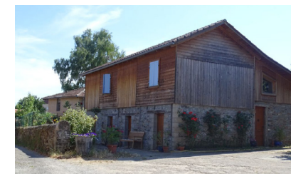
Construction en retrait permettant de conserver un mur en pierre dans le bourg ancien
