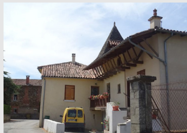
Couleur de façade adaptée, éléments de décor correctement intégrés et toiture conservée (Saint-Etienne)
