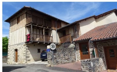
Rénovation réussie du bâti ancien : respect des matériaux et des éléments de décor (Saint-Etienne)
