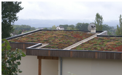
Exemple de toiture végétalisée à Sioniac, 19 (Source : Architecture sur Mesure, Monique Frosch)
