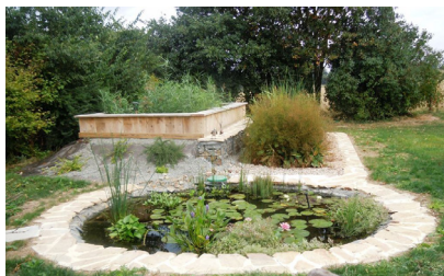
Exemples de système autonome d'assainissement écologique : en haut avec un coffrage en bois, en bas avec une mare en sortie (source : Aquatiris)
